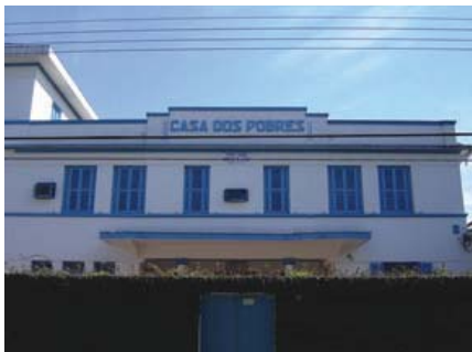
Casa dos Pobres
